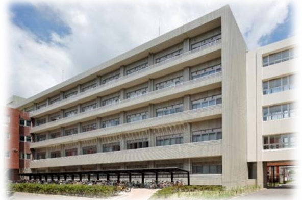
鍋島キャンパス：医学部臨床研究棟改修 (平成27年12月改修完了)
